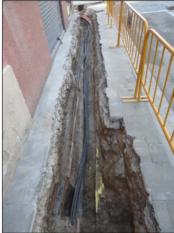
Derivació de la Rasa 100 a l'alçada del C. del Arc del Teatre, amb abundància de serveis anteriors
