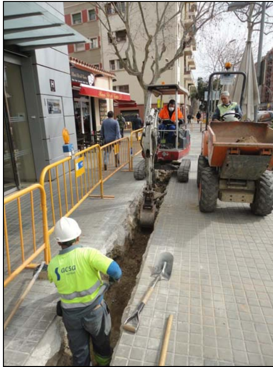
Treballs de rebaix mecànic de la Rasa 100
